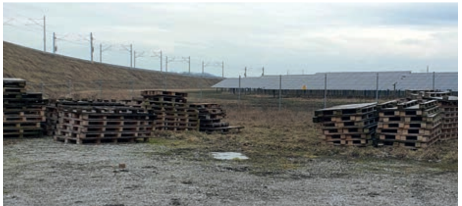
Die Photovoltaikanlage in der Neufahrner Gegenkurve kurz nach der Fertigstellung. Foto: HF
